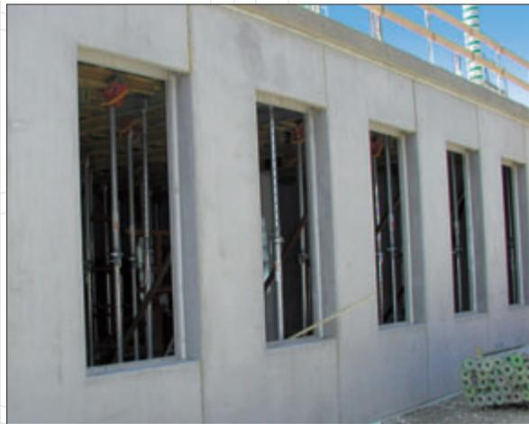
Beispiel für typische Anwendung im Gewerbebau mit integrierter Fensterabschalung in Friedrichshafen
