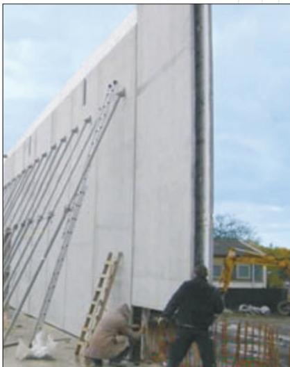
Syspro®PART-thermo-Elemente in Marl mit eingespanntem Wandfuß
