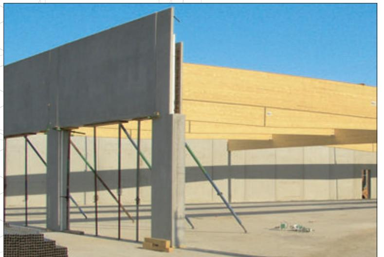
Beispiel für Gewerbebau mit Holzbinderkonstruktion in der Ausführung als wandartiger Träger
