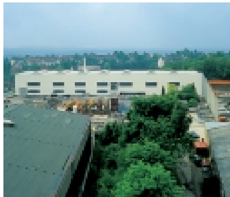
Just-in-time-Logistik für den reibungslosen Fortschritt am Bau.
