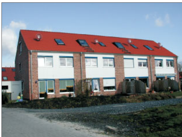
Reihenhausanlage erstellt mit Syspro Massivbausystem
