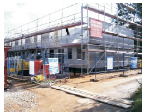
Reihenhaus mit Syspro-Fertigteilen im Rohbau
