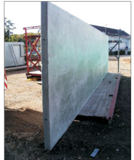
Haustrennwände 0,10 x 12,0 m
