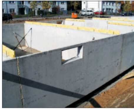
Syspro-Doppelwand und Haustrennwände im Kellergeschoß
