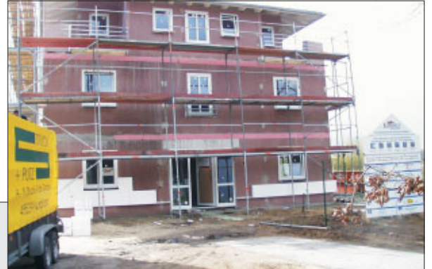
Wohnhaus erstellt mit Sysproton-Bauteilen
