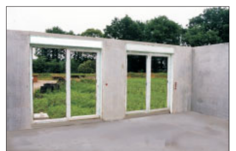
Massivwand mit integrierten Fenstern
