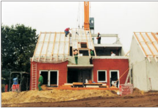
Massivdachelemente des Syspro-Systems bei der Montage
