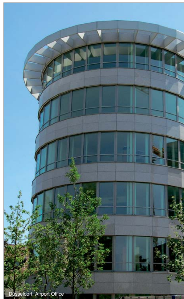
Kranhäuser am Rheinauhafen in Köln
