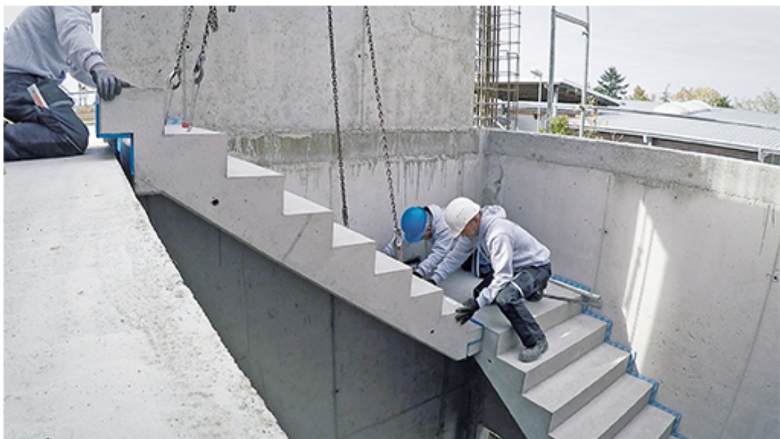
Bild (12.2): Montage einer geraden Treppe
