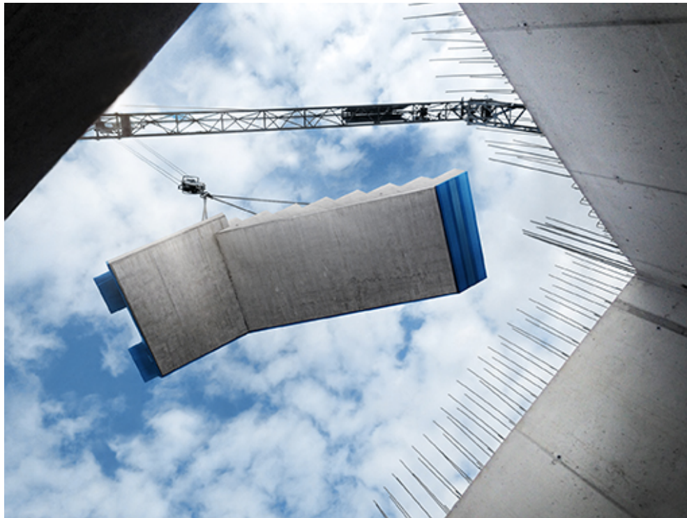
Bild (12.1): Einschwenken einer geraden Treppe
